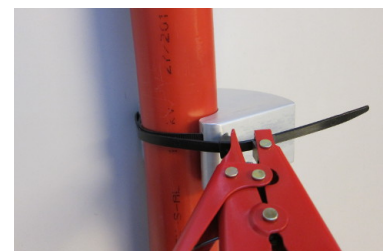
图 11: 使用所提供的工具固定扎条。
